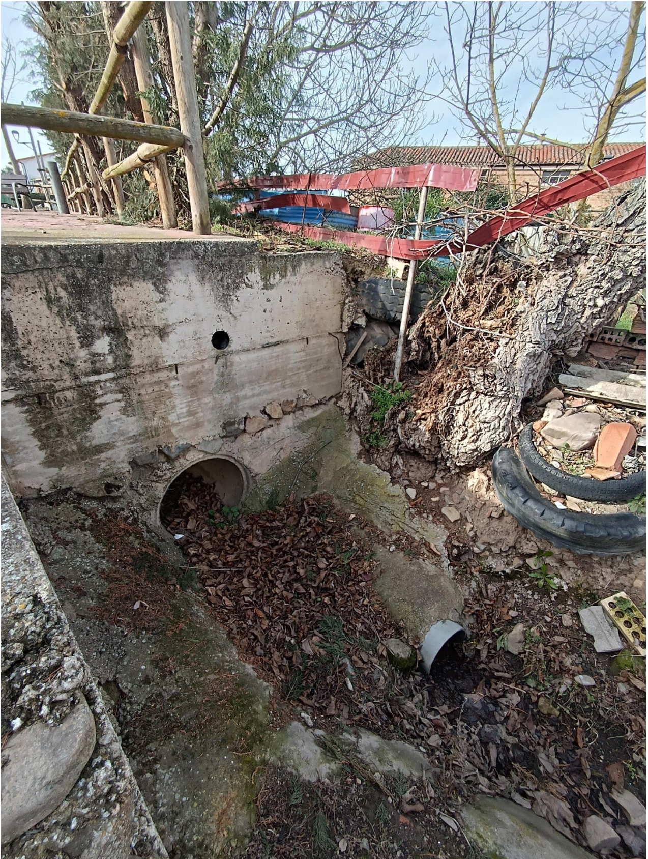
Inicio de canalización abierta, al desagüe de las canalizaciones de cuentas enterradas.
