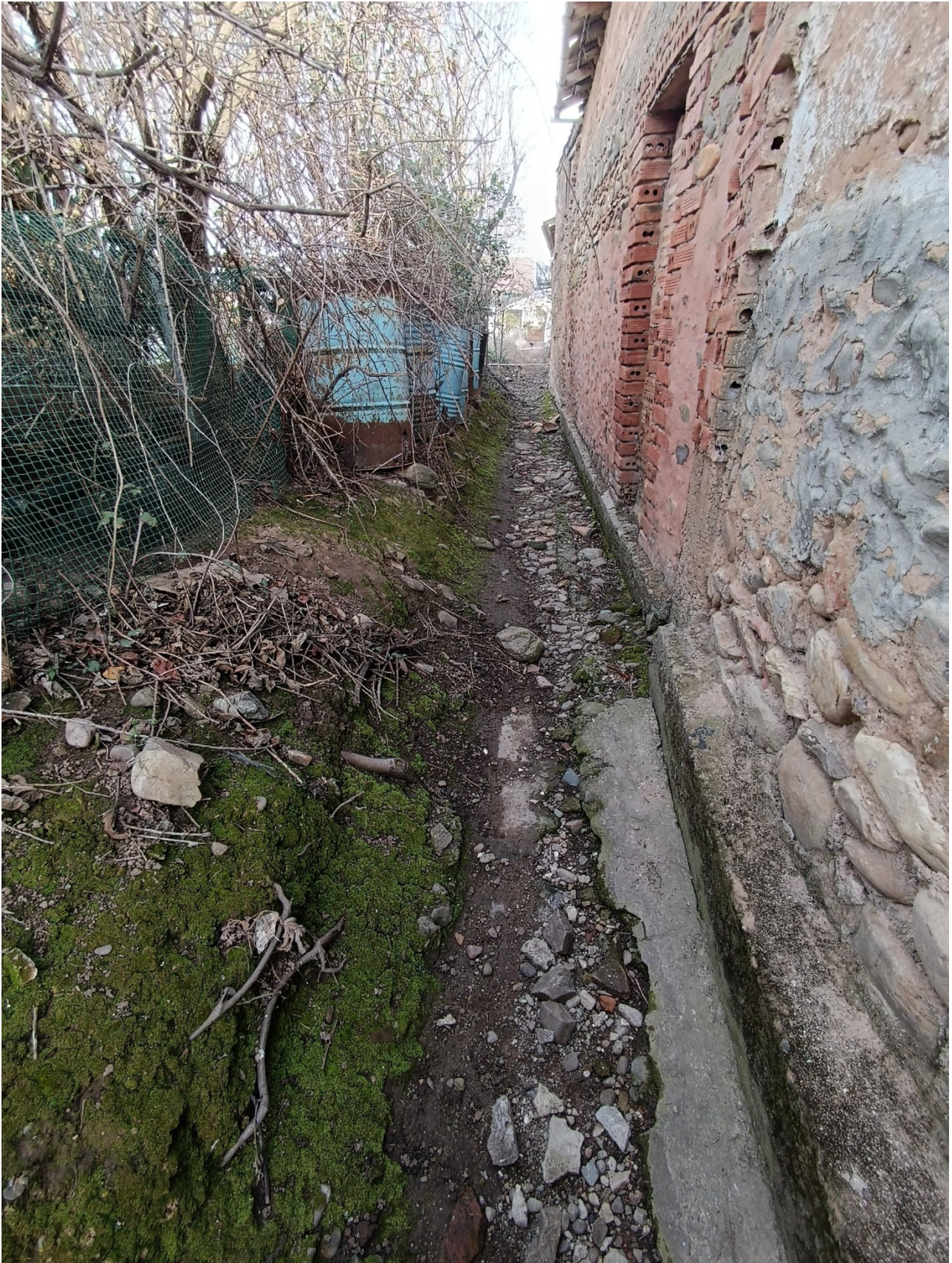
Total anegación de canalización abierta.
