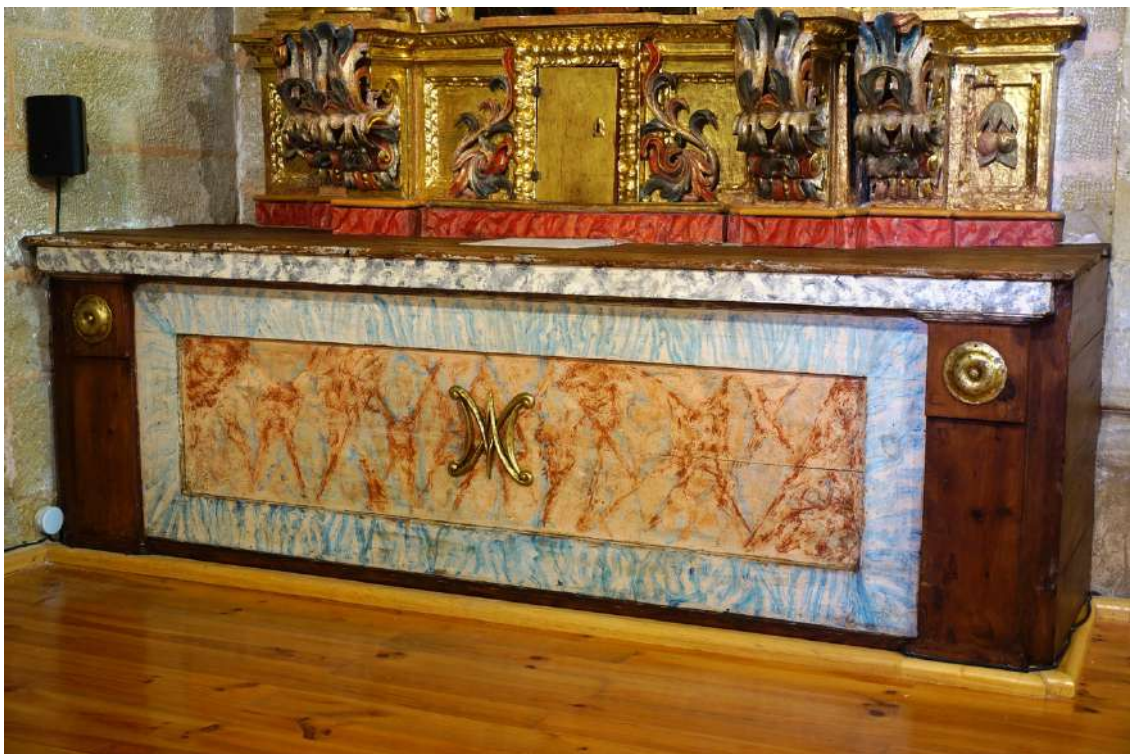
Vista general de la mesa de altar del retablo de San Isidro después de los tratamientos de conservación y restauración
