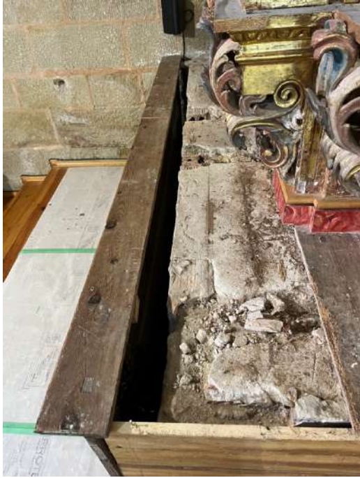
Proceso de desmontaje de tableros sueltos, rotos y añadidos modernos con DM. Así, como la sustitución de travesaños en mal estado por otros mas adecuados para soportar la humedad y la manipulación en la mesa de altar del retablo de San Isidro
