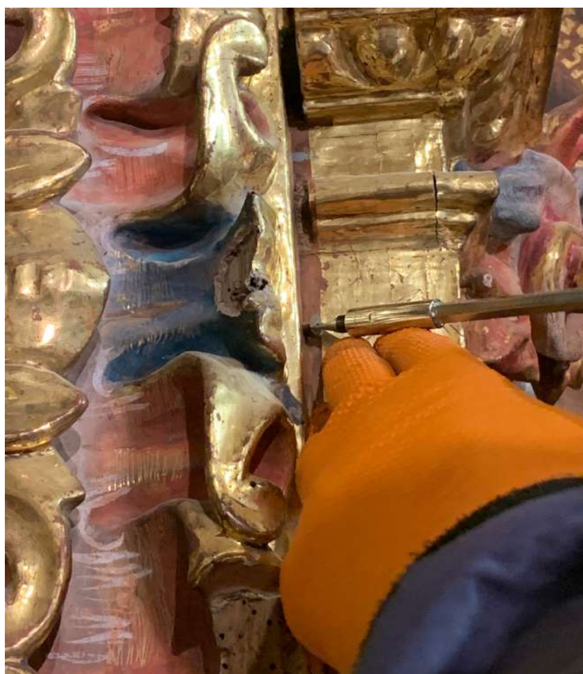
Eliminación de tornillos modernos en el retablo de San Isidro
