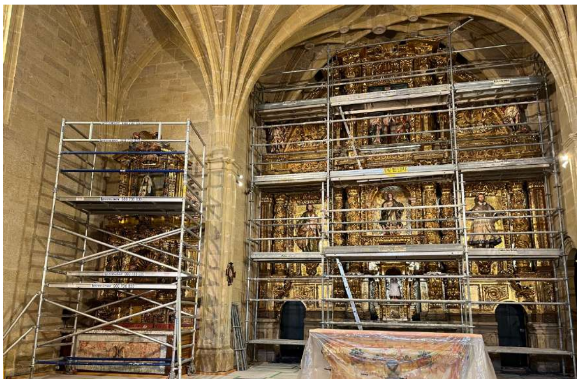
Vista de la instalación y montaje de andamios en el retablo de San Isidro y retablo mayor
