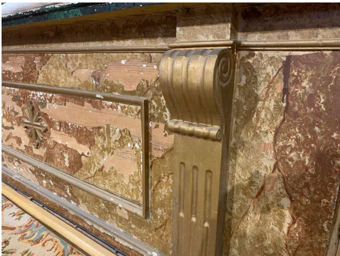
Detalle del frente de altar del retablo mayor con levantamiento de policromía, así como pérdidas de policromía.
