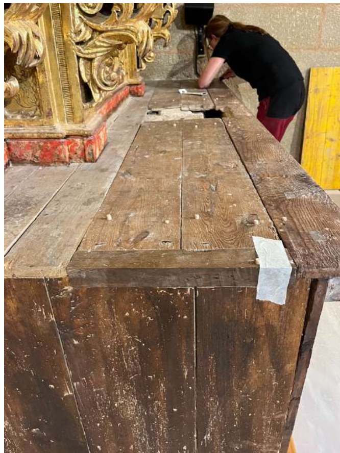
Proceso de refuerzo y ajustes de tableros con distintos niveles en la mesa de altar del retablo de San Bartolomé
