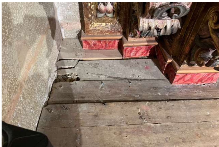
Detalle de la mesa de altar con listones de madera descohesionados, sustitución de listones por otros nuevos de DM, y refuerzo estructural interno suelto
