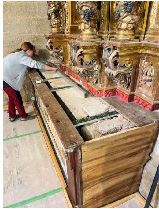
Proceso de desmontaje de tableros sueltos, rotos y añadidos modernos con DM. Así, como la sustitución de travesaños en mal estado por otros mas adecuados para soportar la humedad y la manipulación en la mesa de altar del retablo de San Isidro
