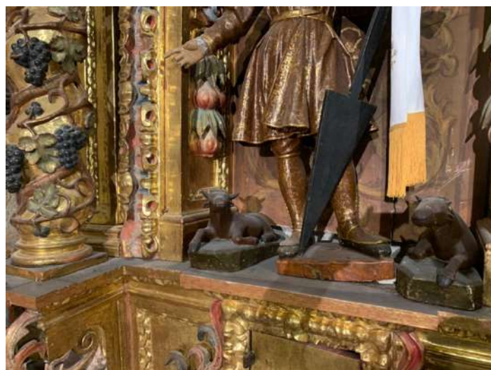
Detalle del primer cuerpo del retablo de San Isidro con acumulación de suciedad
