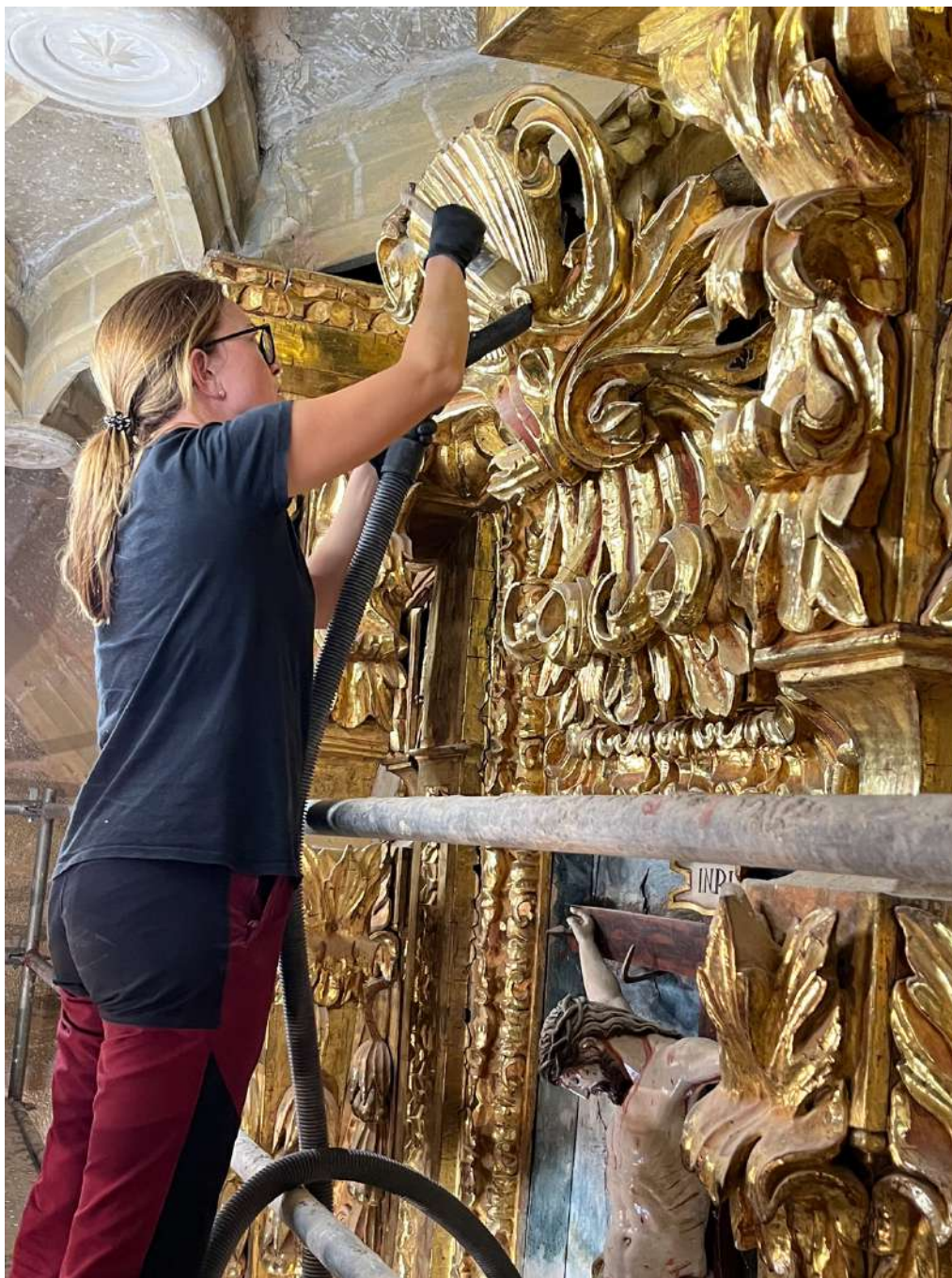
Detalle de la limpieza superficial mediante aspiración controlada
