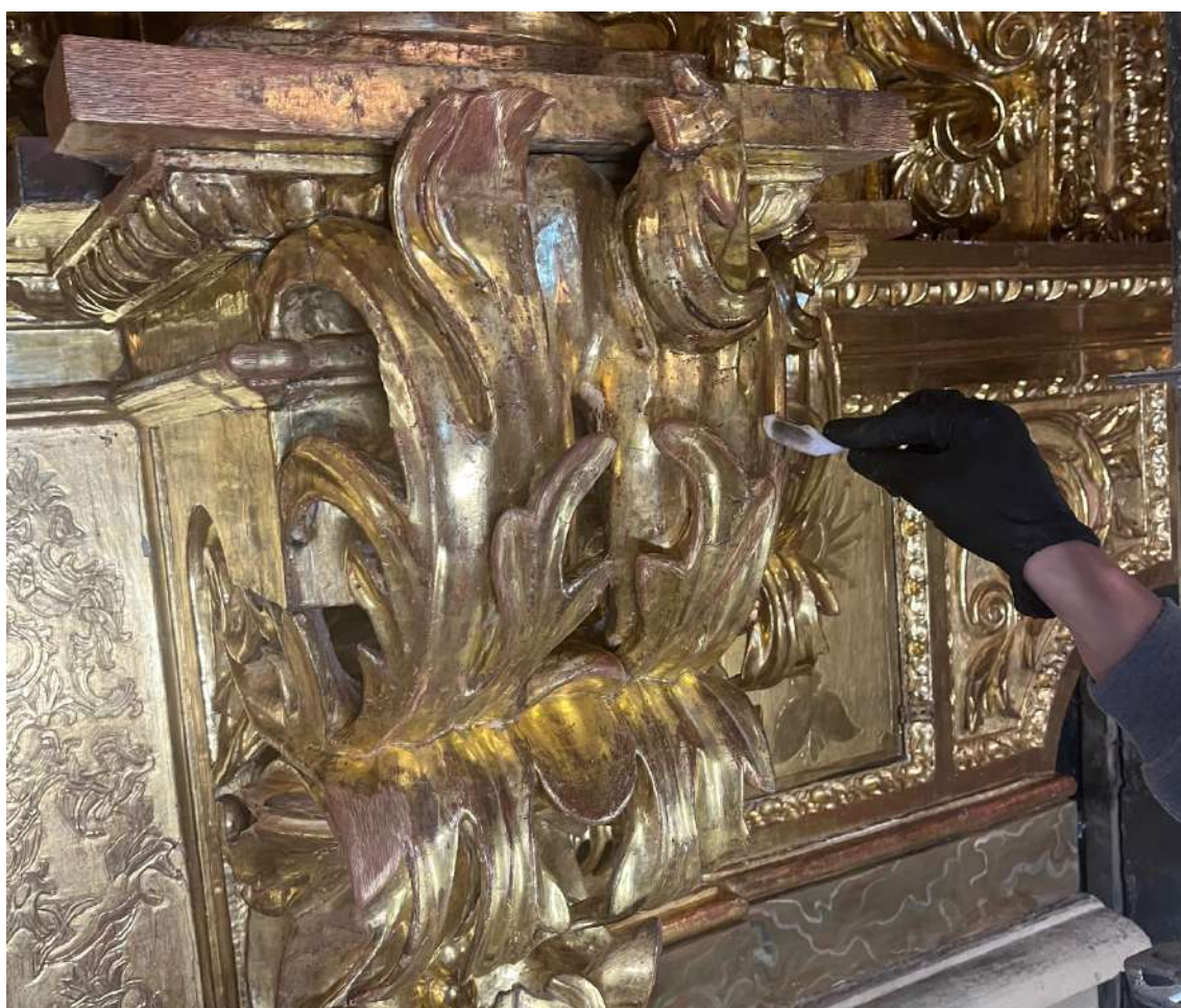
Detalle de la limpieza físico-química de la suciedad adherida
